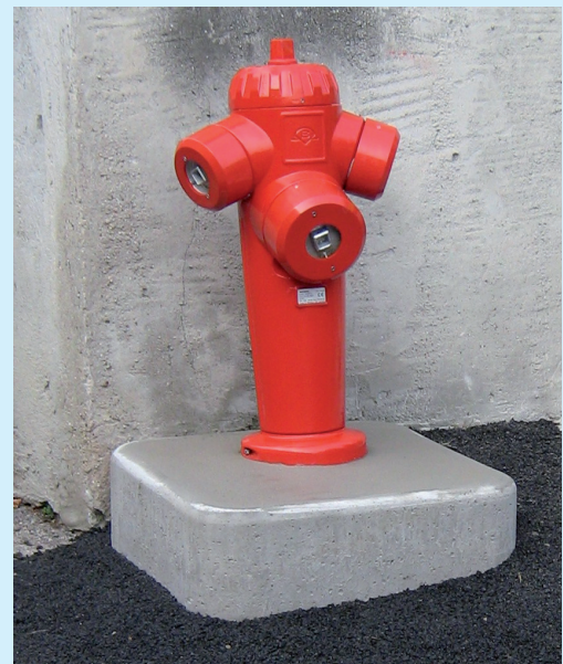
Poteau SAPHIR posé dans une rue en pente
